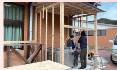
2月6日時点のバイオガスプラント まずは断熱するための建屋から製作!
