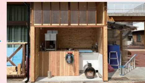
2月20日時点のバイオガスプラント 中古品の組み合わせに試行錯誤!
